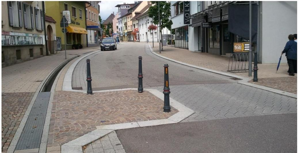
Abb. 27 Einengung im Zuge Tempo-30-Zone und Fahrbahnteiler (hinten)
