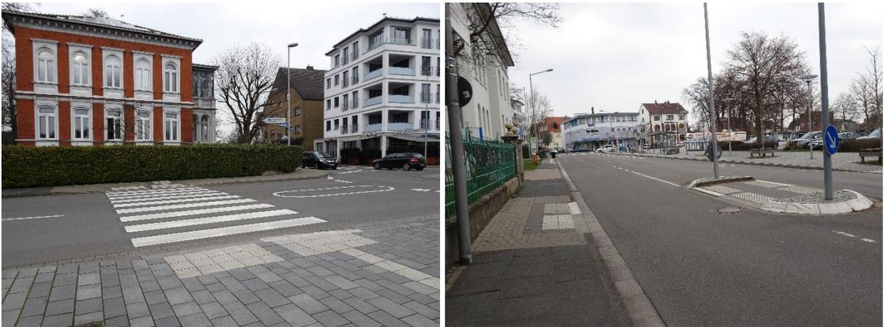
Abb. 71 Differenzierte Bordhöhe mit Nullabsenkung und 3 cm Bord am Marktplatz
