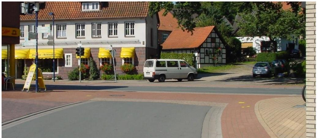
Abb. 30 Aufpflasterung im Einmündungsbereich
