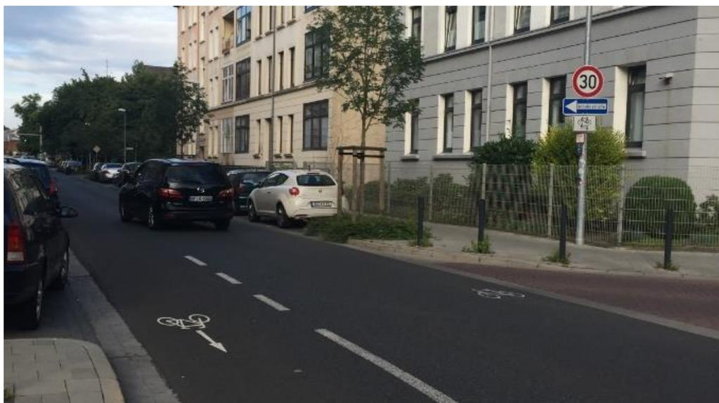
Abb. 53 Markierung von Fahrradpiktogrammen auf der Fahrbahn (Braunschweig)
