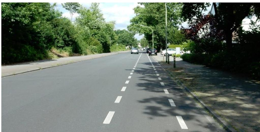
Abb. 55 Einseitige Markierung von Schutzstreifen (Osnabrück)
